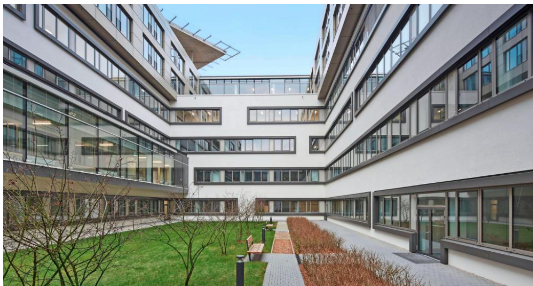
In vier Jahren Bauzeit ist ein zukunftsweisender Bau entstanden, der die hohen Ansprüche einer modernen Medizin mehr als erfüllt.
