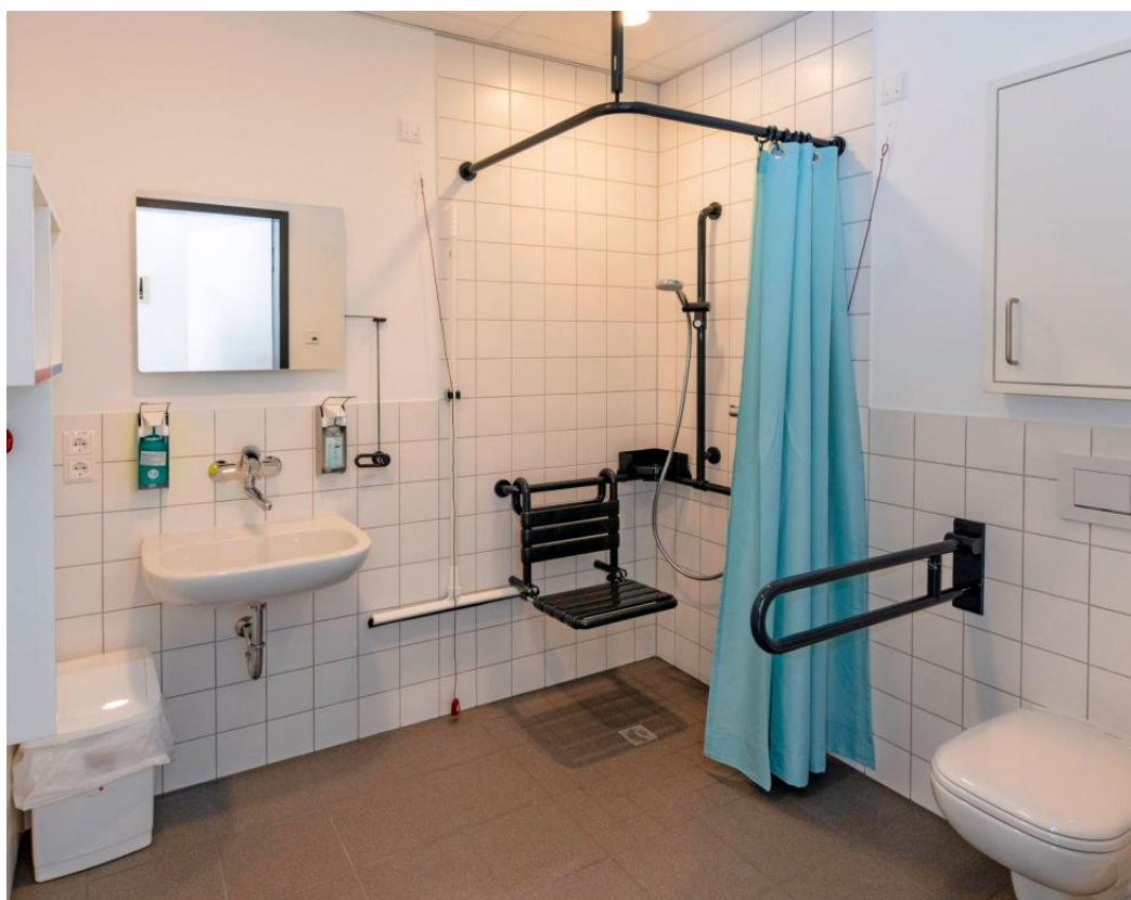
Jedes Patientenzimmer in der Geriatrischen Rehaklinik verfügt über ein eigenes Bad mit barrierefreier Dusche, unterfahrbarem Waschbecken und Toilette.
