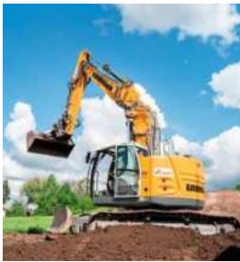
Das Unternehmen deckt das gesamte Spektrum im Bereich Bau ab. Foto: STAUCH
