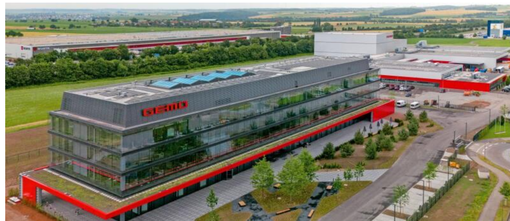
Im Frühjahr 2024 war der Neubau bezugsfertig. Aus Nachhaltigkeitsaspekten besteht die Glasfront aus einer Doppelverglasung mit einem sehr guten Wärme- und Schalldämmeffekt. Das Atrium bekam ebenfalls ein Glasdach. Tageslicht findet so überall seinen Weg ins Gebäude. Fotos: GEMÜ/Bernhard Kahrmann
