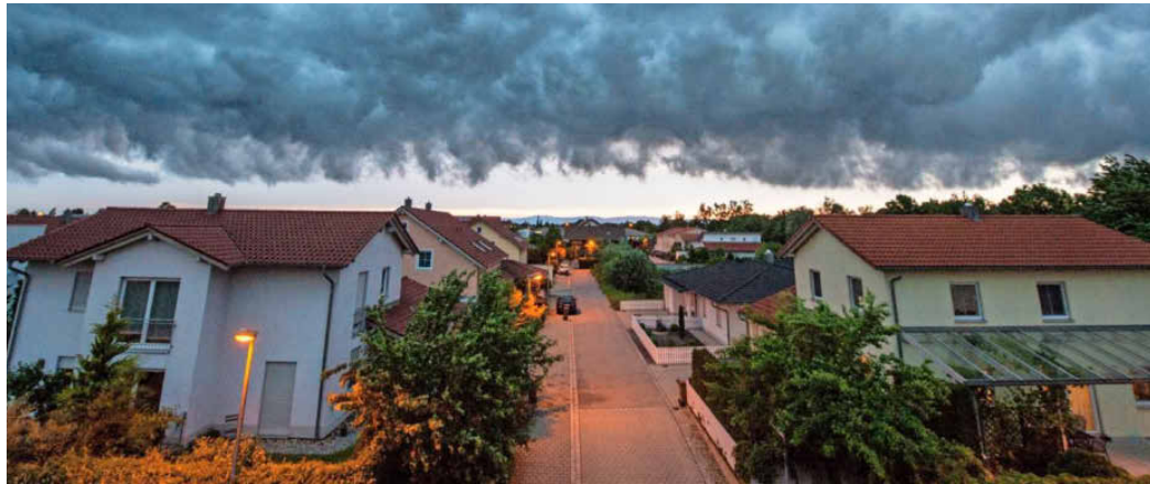
Da braut sich was zusammen: Schäden am Haus sollten immer zeitnah gemeldet werden.
