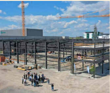
Am Neubau von Groninger wurde Richtfest gefeiert. Foto: Groninger
