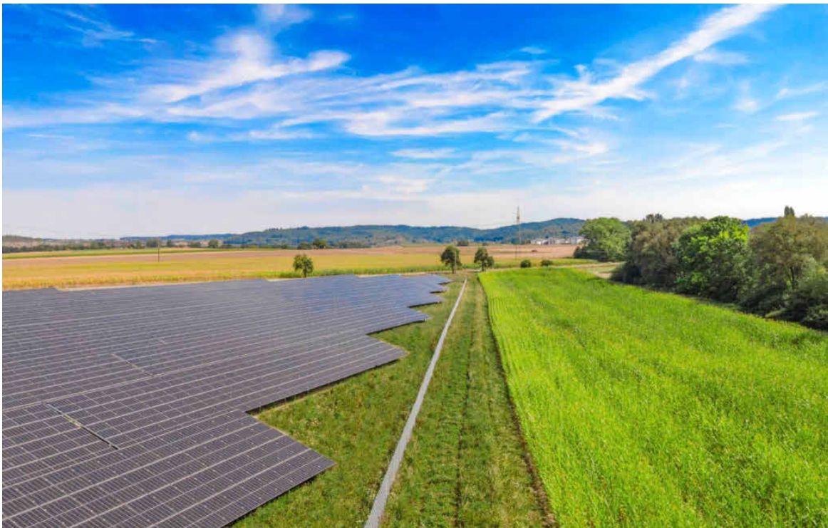
Mehr als 24 000 Module werden künftig auf der PV-Freiflächenanlage „Steinacker“ klimafreundlichen Strom erzeugen und damit einen wichtigen Beitrag zur regionalen Stromversorgung leisten. Foto: privat
