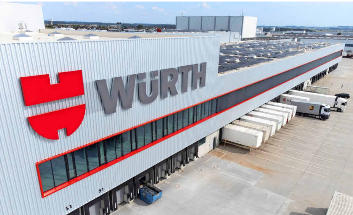
Im hochautomatisierten Vertriebszentrum West am Hauptsitz in Künzelsau-Gaisbach kommen modernste, KI-gestützte Roboter in der Kommissionierung zum Einsatz. Foto: Würth
