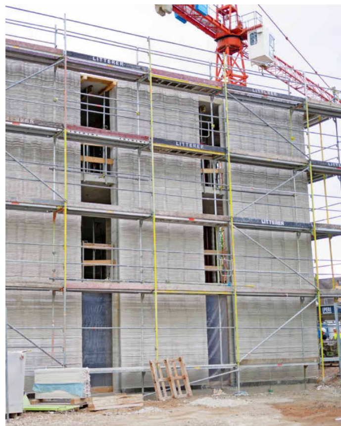
Dieser Rohbau eines Hauses ist mit Hilfe eines speziellen 3D-Druckers entstanden.
