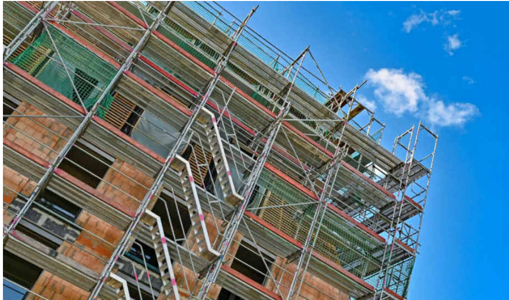
Einer Baustelle einen Besuch abstatten, ist das Recht der Eigentümer. Nur so können sie Fortschritte und Ausführung der Arbeiten kontrollieren.
