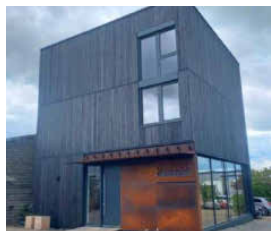
Das neue Verwaltungsgebäude der Firma. Foto: privat
