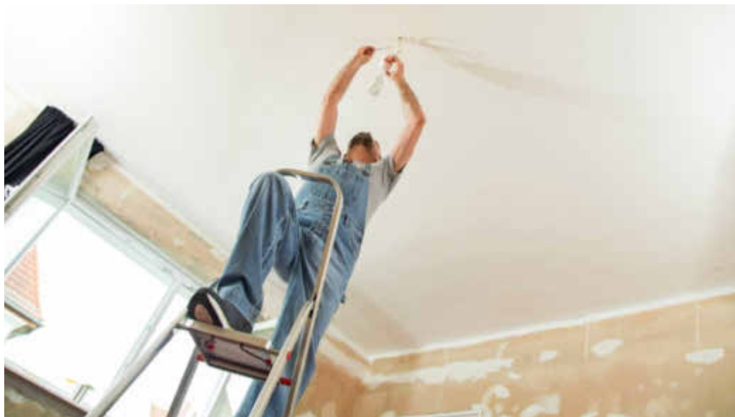
Bei Arbeiten in der Höhe ist es wichtig, eine stabile Leiter zu verwenden und darauf zu achten, dass diese auch sicher einrastet.
