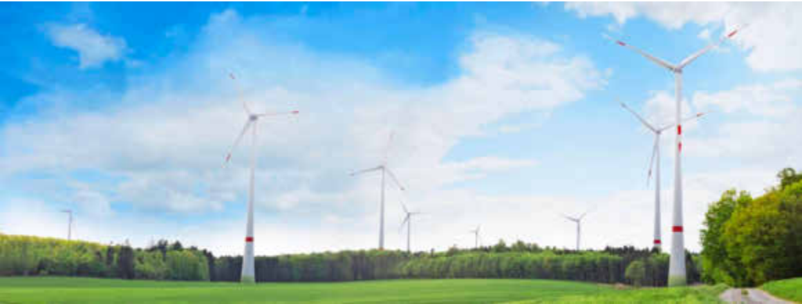
Der Windpark Harthäuser Wald – mit 18 Anlagen und einer Gesamtleistung von 54 Megawatt einer der leistungsstärksten Windparks in Baden-Württemberg. Foto: ZEAG Energie AG
