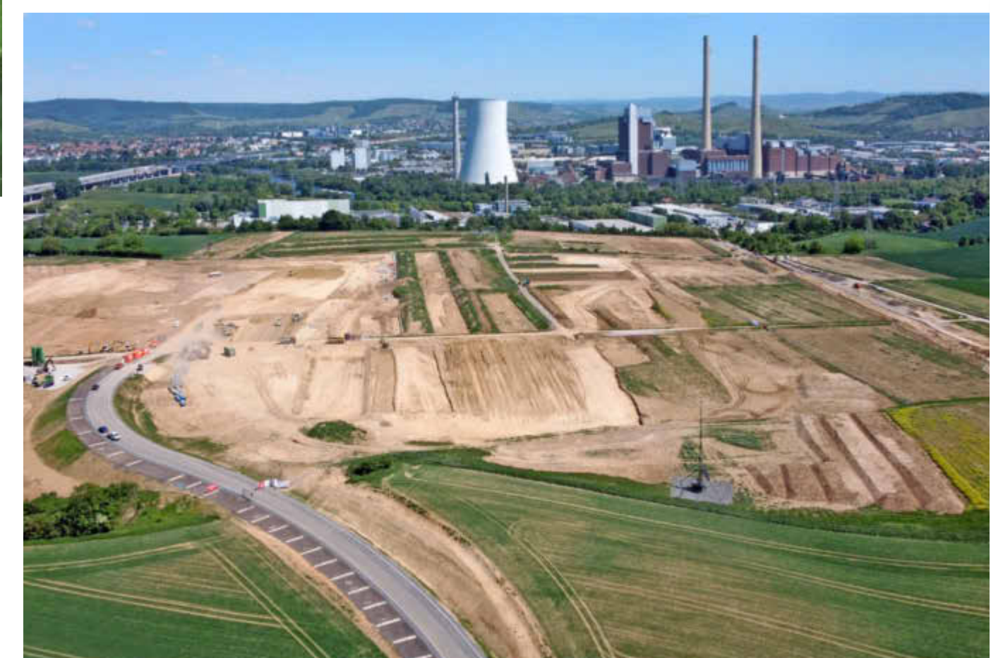
In den Steinäckern, wo in den nächsten Jahren der Ipai-Campus entsteht, hat vor einigen Tagen das Einrichten der Baustelle begonnen. Bis zum offiziellen Spatenstich im November wird das Gelände begradigt. Foto: Ralf Seidel
