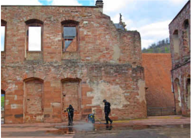
Der Boden des Englischen Baus am Heidelberger Schloss soll wieder rutschsicher werden. Darum wird hier geputzt. Fotos: Heiko Fritze
