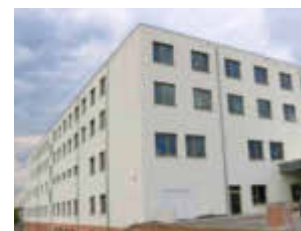
Der Neubau des Hohenloher Krankenhauses wird im Laufe des Jahres fertiggestellt. Foto: rei
