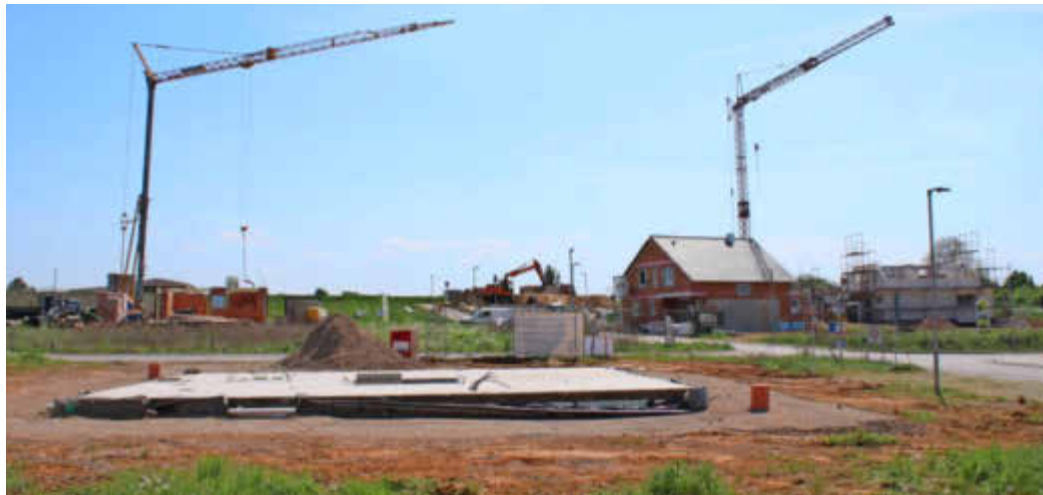
Im Gebiet Klingenäcker in Sontheim wird aktuell an mehreren Stellen gebaut.
