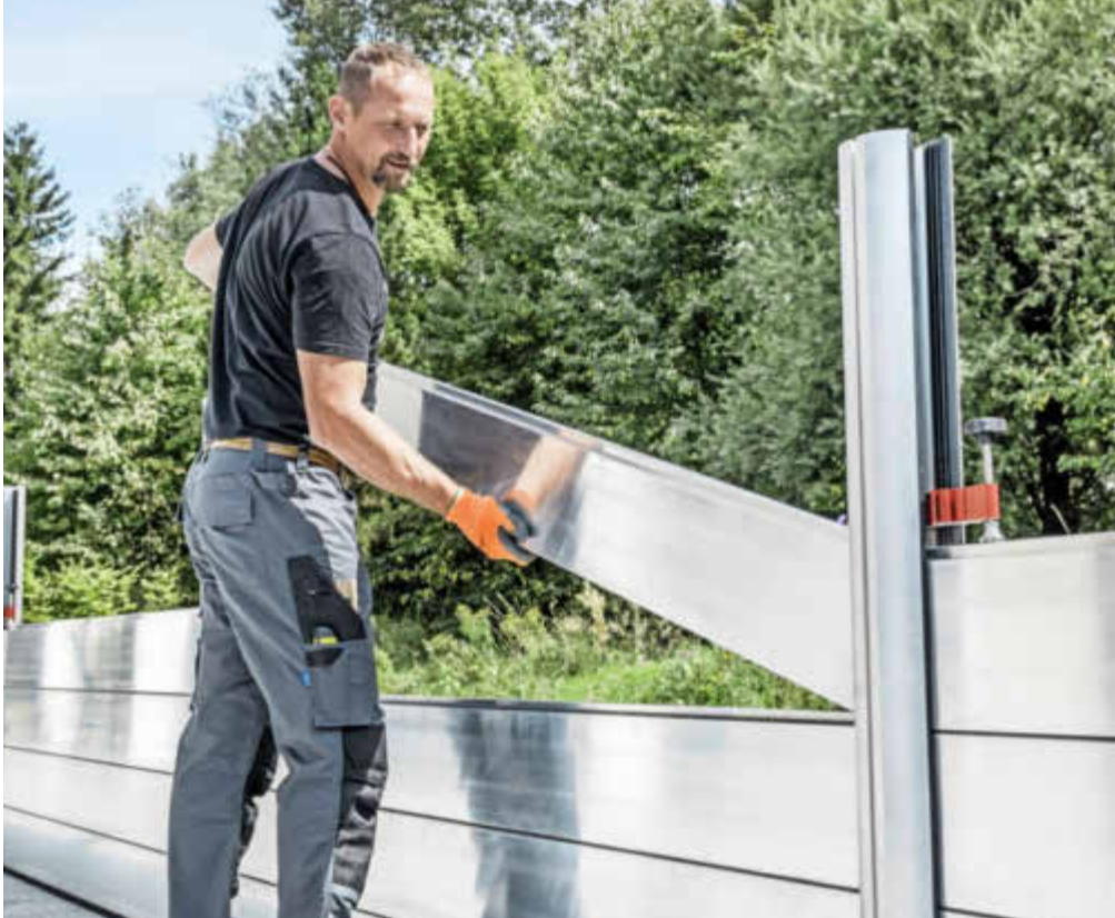
Einfach anzubringen: Der Schutz ist von nur einer Person und ohne Spezialwerkzeug installierbar und kann auch leicht wieder entfernt werden. Fotos: PREFA
