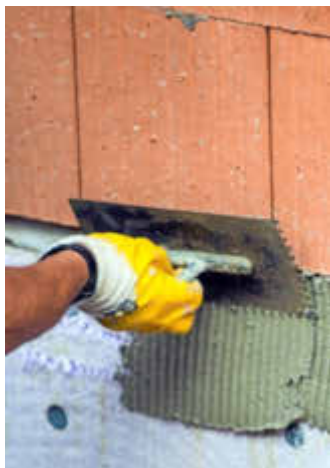
Ein Maurer trägt Mörtel auf die Wand auf. Foto: Lino Mirgeler/dpa
