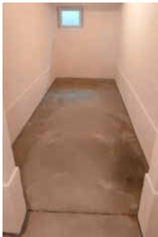
Nachher: Die sanierten Wände wirken wie neu. Fotos: privat
