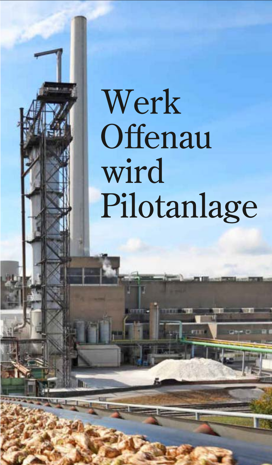
Die Beheizung des Offenauer Südzucker-Werks soll sich ändern: Künftig soll eine Wärmepumpe einen Teil des Wasserdampfs erzeugen. Foto: Archiv/Veigel
