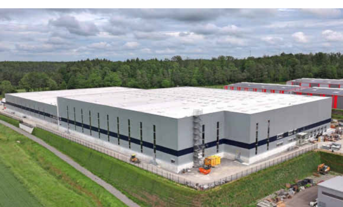
Mit einem Investitionsvolumen von 45 Millionen Euro und einer Grundstücksfläche von insgesamt vier Hektar entsteht eine Anlage mit einer Gebäudefläche von 20000 Quadratmetern. Foto: REISSER
