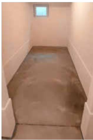
Nachher: Die sanierten Wände wirken wie neu. Fotos: Die Thonigs
