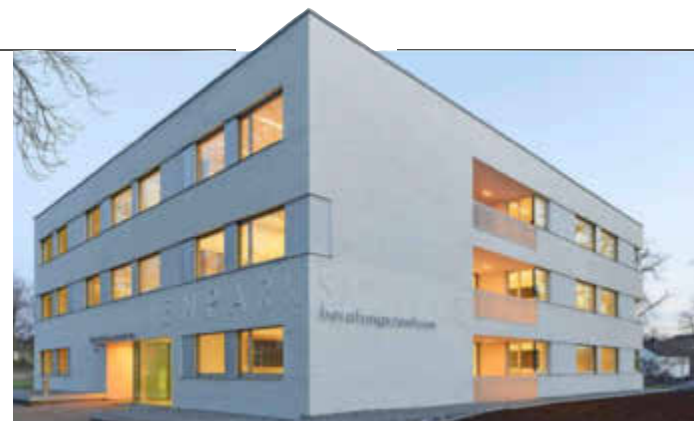
Lindenparkschule: Die neu geschaffenen, teilweise flexiblen Räume bieten viel Platz für Beratung und Unterricht. Foto: Oliver Rieger/ Stuttgart
