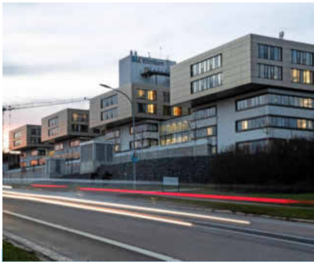
Das SLK-Klinikum am Gesundbrunnen wird gerade erweitert und modernisiert. Foto: Andreas Veigel
