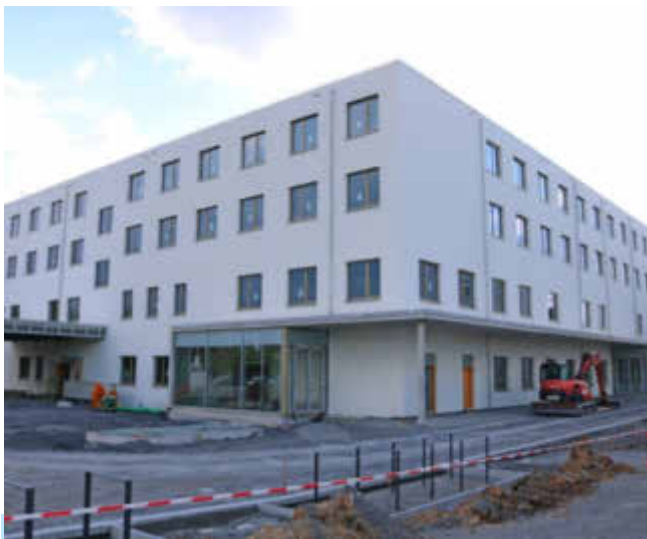
In Öhringen entsteht der Neubau für das Hohenloher Krankenhaus. Foto: Ralf Reichert
