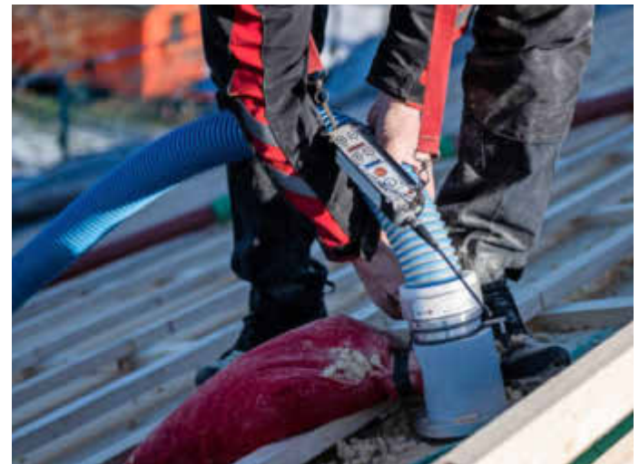
Über das Rohr gelangt Wärmedämmstoff durch eine hochleistungsfähige Einblasmaschine direkt unter das Dach. Foto: Silas Stein/dpa
