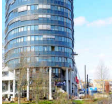
Die Bank Santander ist im Heilbronner Neckarturm ansässig. Fotos: Archiv
