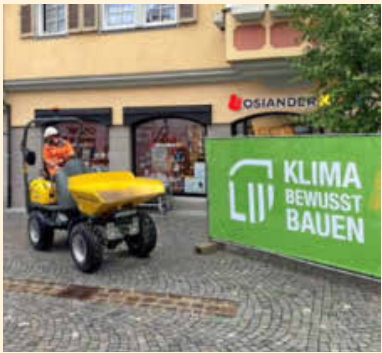
Leonhard Weiss testet klimabewusstes Bauen. Foto: privat
