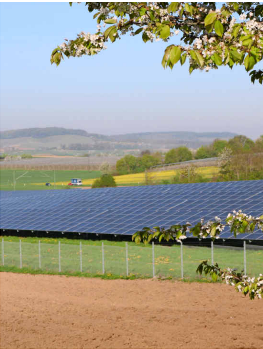
Mittlerweile sind 310 Hektar in Heilbronn-Franken mit Freiflächen-Photovoltaikanlagen belegt, hier bei Öhringen. Insgesamt 953 Hektar müssen bis 2025 ausgewiesen sein. Foto: Archiv/Tscherwitschke
