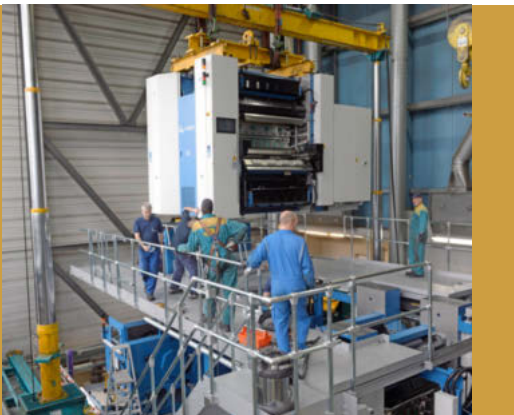
2014: Die neue Druckmaschine wird in der Austraße eingebaut.
